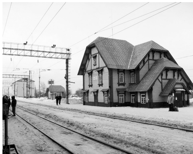
Здание вокзала типа «теремок» сегодня сохранилось лишь на узловой станции Обозерская Северной железной дороги
